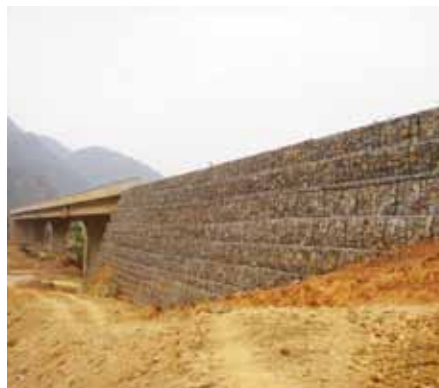
Làm đường dẫn cầu
