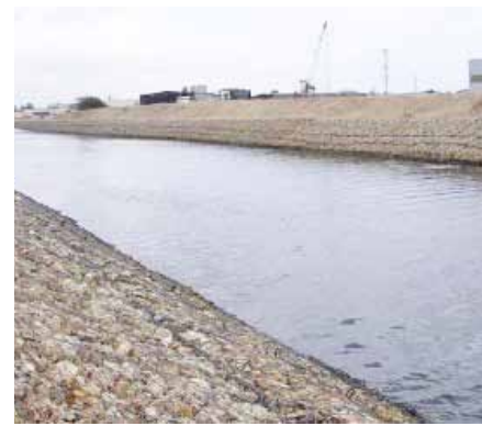
Thi công mái taluy đê kè sông biển, lát dòng kênh mương
