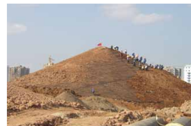
Gia cố mái dốc
