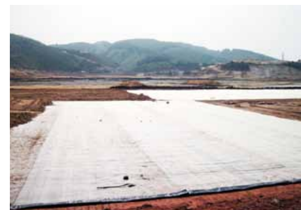
Lót đáy các khu chứa quặng mỏ, bãi thải xỉ
