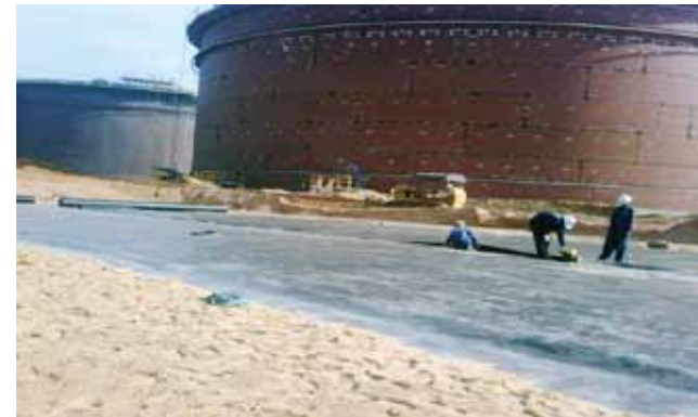
Chống thấm bể chứa xăng dầu, hóa chất
