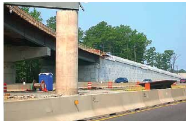
Gia cố đường dẫn đầu cầu
