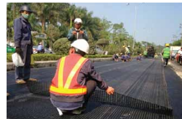
Gia cố mặt đường thảm asphalt (lưới địa KT cốt sợi thủy tinh)
