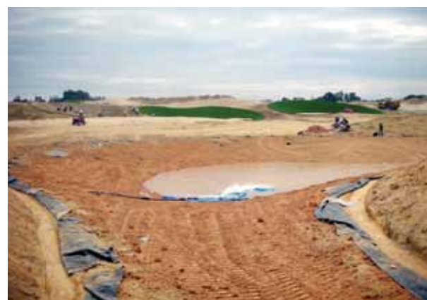
Lót đáy hồ nước sân golf, hồ xử lý nước thải
