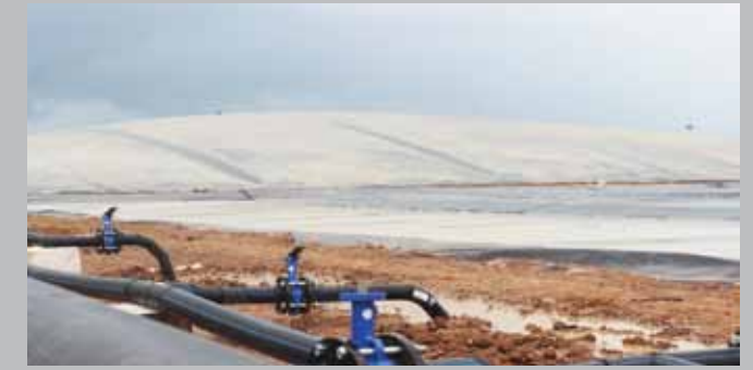
Che phủ các hồ chứa chất thải hồ Biogas trong các khu chăn nuôi
